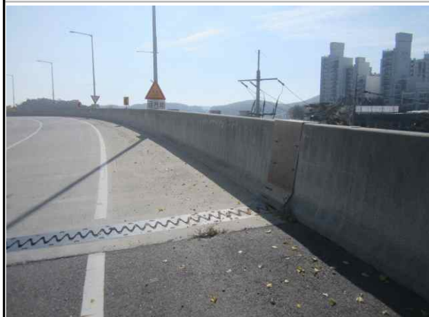
난간 및 연석 전경
